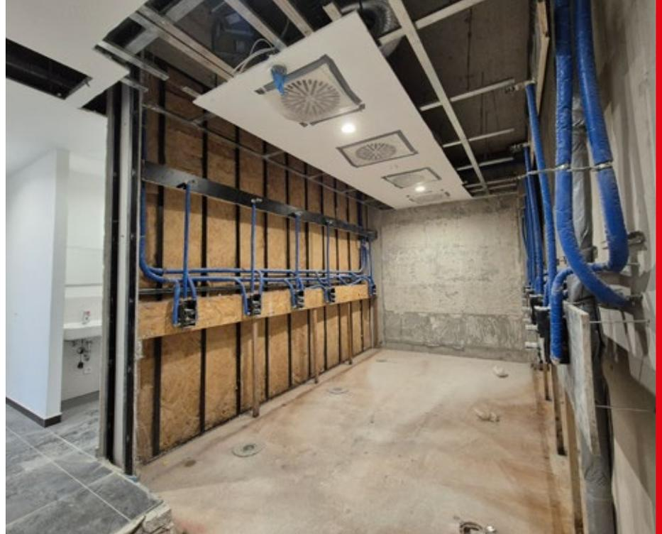
Auch die Wandfliesen, Stellwände, Vorsatzschalen und abgehängten Decken mussten zurückgebaut werden.
